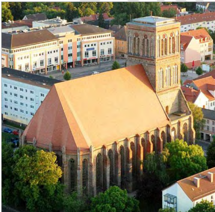
Abbildung 4: Zustand Heute, Wiederaufbau des Daches in voller Höhe, 2011
